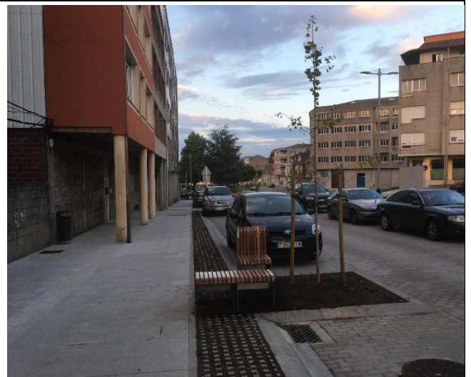
Rúa Xilgaro, na contorna do Fórum: Exemplo integración de mobiliario de produción local. Plataforma segregada con bordo rebasable, e calzada en adoquín
