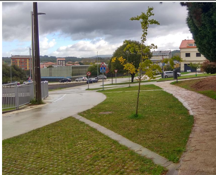
Contorna do Fórum: pavimento permeable con pavicésped.
