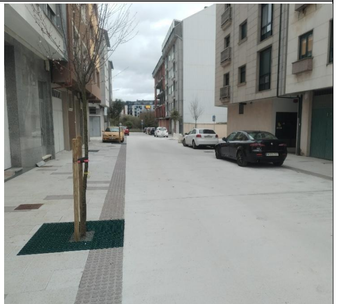
r/ Labarta Pose: Plataforma única, espazo de circulación en formigón. Variante de alcorque con céspede "pisable" permeable, armado con malla plástica.
